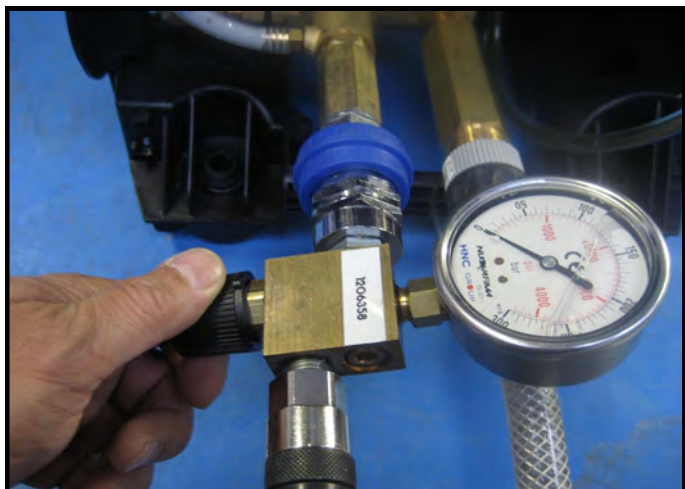
Vérification de la pression retenue
